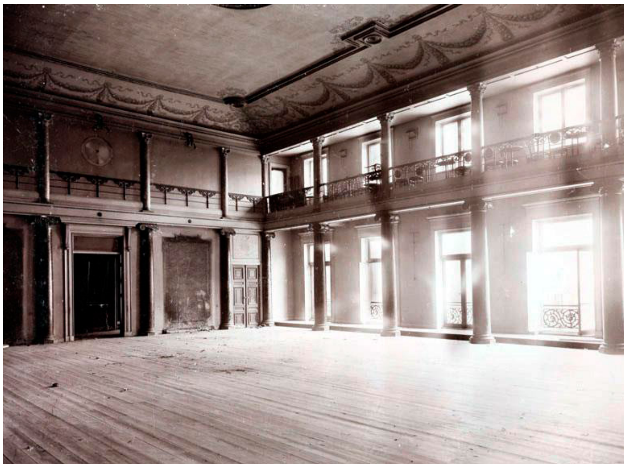
Bild 1. De la Croix's salong före rivningen 1913. Stockholms stadsmuseum.
