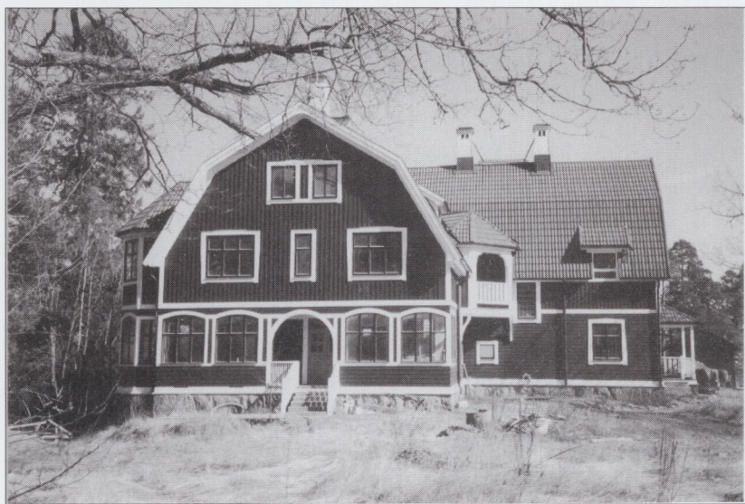
Trevåningsvillan i Saltsjö-Duvnäs. Foto: Per Oldaens 1998.
